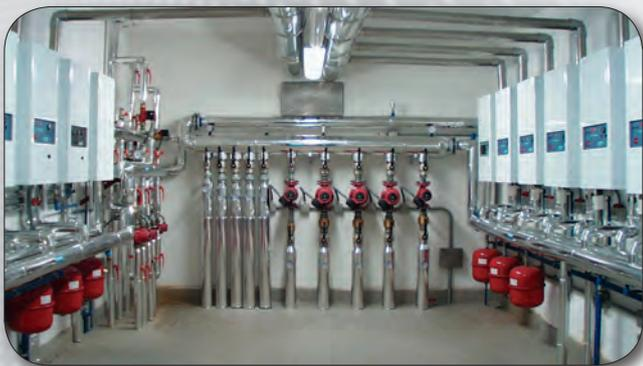
Благодаря подключению котлов COSMOGAS в каскад возможны подключения к новейшим и функциональным системам отопления (и производства ГВС) для больших объемов в жилищном, коммерческом или производственном секторах. Изменяя количество и мощность запрашиваемого тепла можно обогреть любое помещение (с системами на радиаторах, «теплыми полами», конвекторами), и при этом сэкономить до 50% стоимости энергоресурсов.
